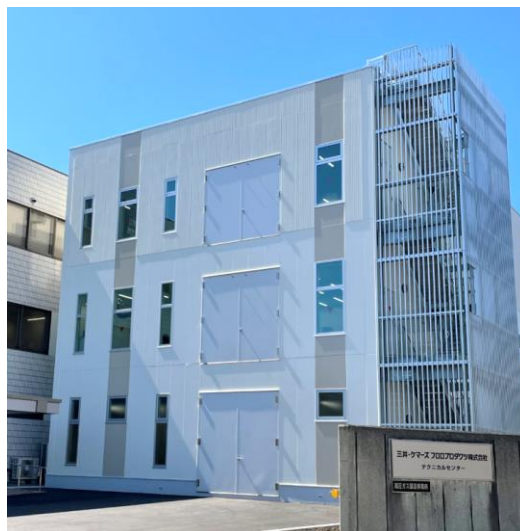
テクニカルセンター 新実験棟 外観
