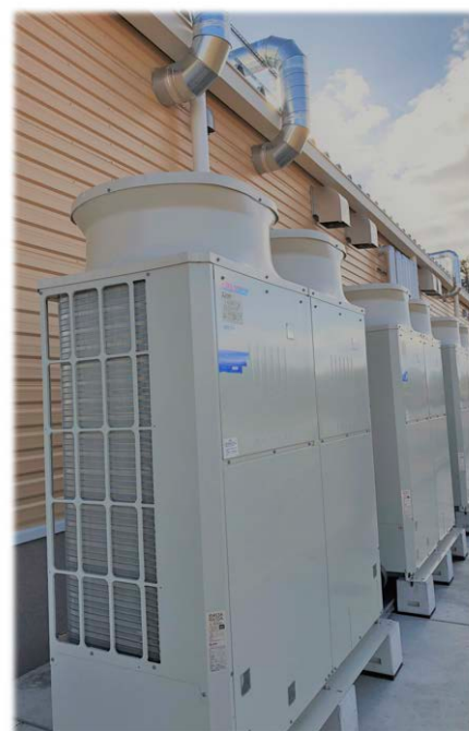
「オプテオン™XP41(R-463A-J)」採用 三菱電機製コンデンシングユニット「ECOV DUAL」
